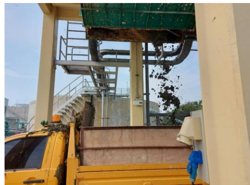
(ข) ตัวอย่างการนำตะกอนที่ดูดขึ้นมาจากบ่อพักน้ำจากตะกอนจากระบบปรับปรุงคุณภาพน้ำไปถมที่ลุ่มภายในโรงไฟฟ้า
