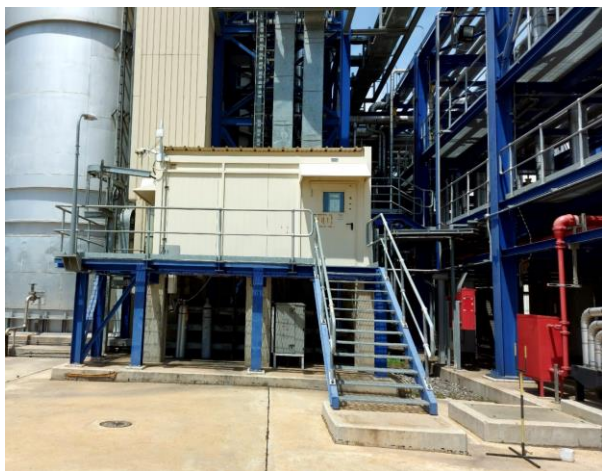
รูปที่ ข.2-1 ระบบตรวจสอบคุณภาพอากาศจากปล่องแบบต่อเนื่อง (CEMS)
