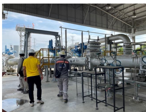
(ก) การทดสอบและตรวจสอบอุปกรณ์นิรภัยแบบระบาย (Safety Valve) ของสถานที่ใช้ก๊าซธรรมชาติ
